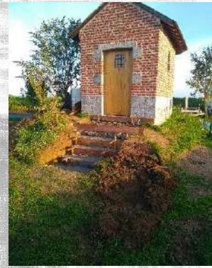
Travaux de déblaiement et de terrassement pour la pose de l'escalier massif.
