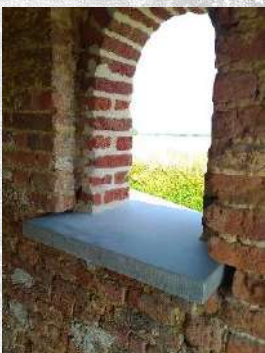
Pose d'appuis de fenêtres en pierre bleue et des menuiseries.
