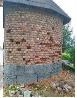
Travaux de déjointement et de reprise de la maçonnerie.
