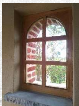
Pose d'appuis de fenêtres en pierre bleue et des menuiseries.
