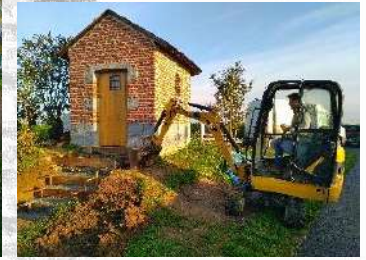
Travaux de déblaiement et de terrassement pour la pose de l'escalier massif.
