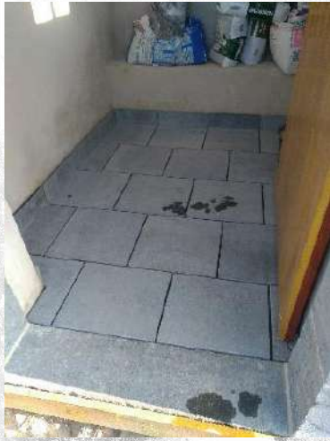
Pose du carrelage à la chaux traditionnelle.
