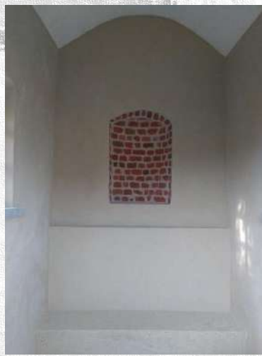
Travaux d'enduisage à la chaux traditionnelle et plafonnage au plâtre.
