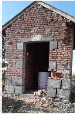
Travaux de déjointement et de reprise de la maçonnerie.
